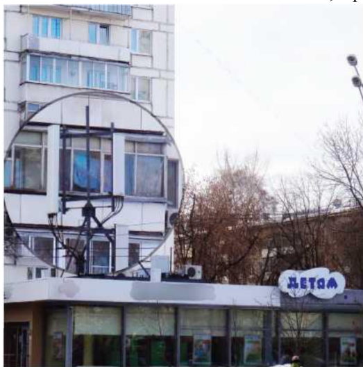
Рис. 6. Расположение БС на уровне окон жилого дома на
